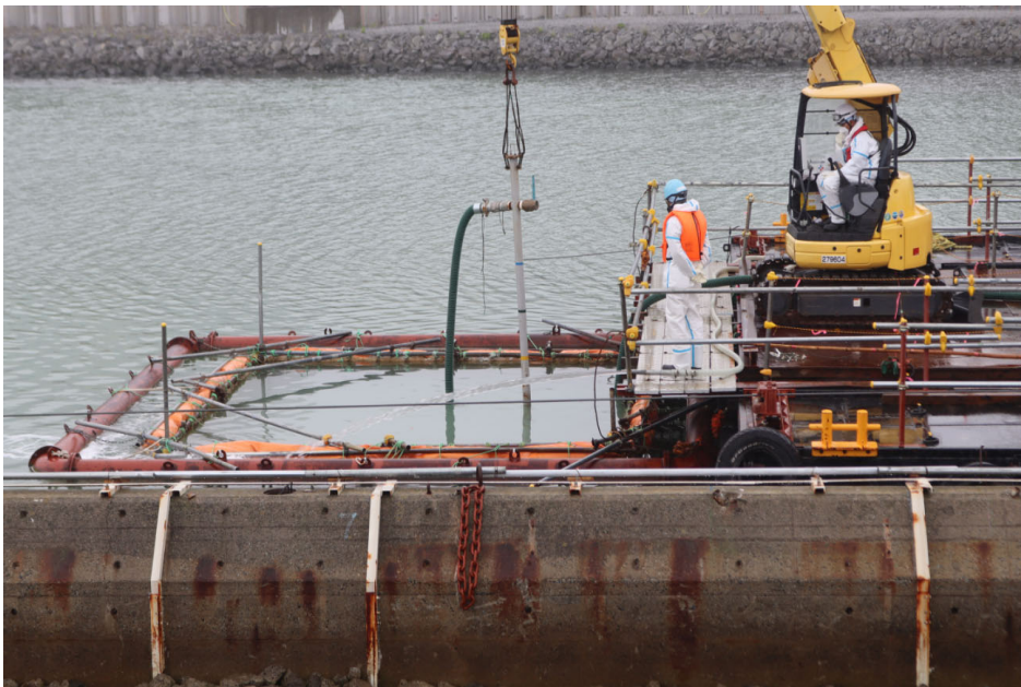
図2.海底再被覆工事(2層目の覆土施工)の状況 (2024年5月16日撮影)
