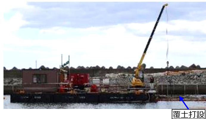
図5.ユニフロート台船による2層目の覆土投入状況
