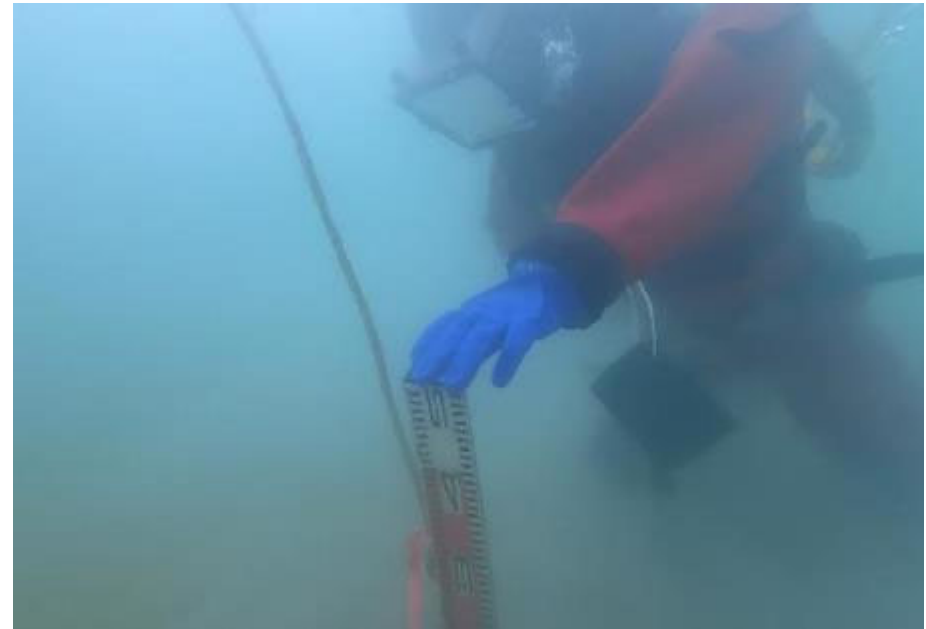
図3.作業員(潜水土)による測量作業の状況 (2024年5月16日撮影)
