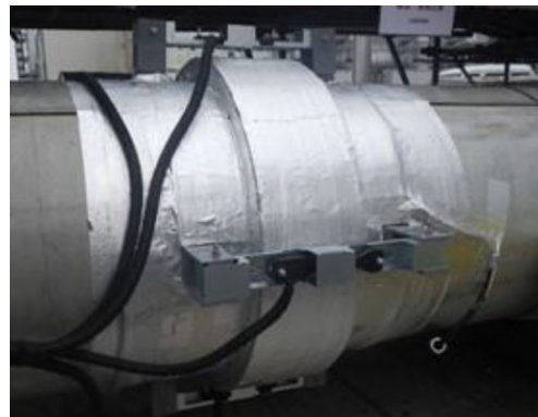
取付状況：現地モックアップ
