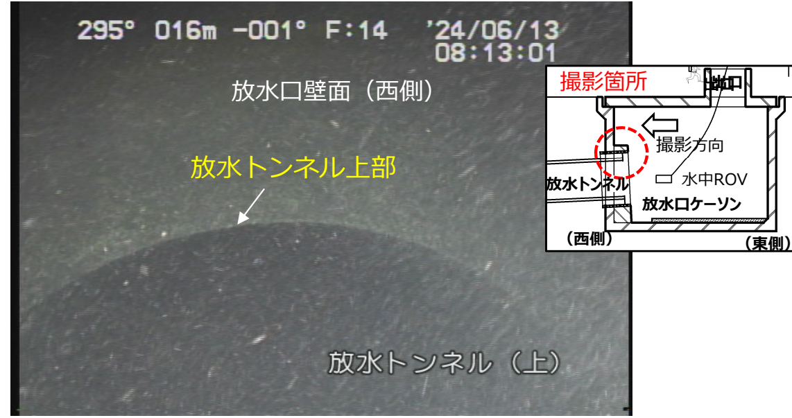
トンネル出口 (放水口ケーソン接続箇所) の状況
