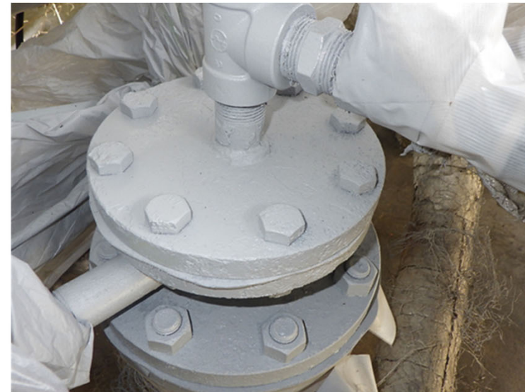
防錆塗装後の凍結管
