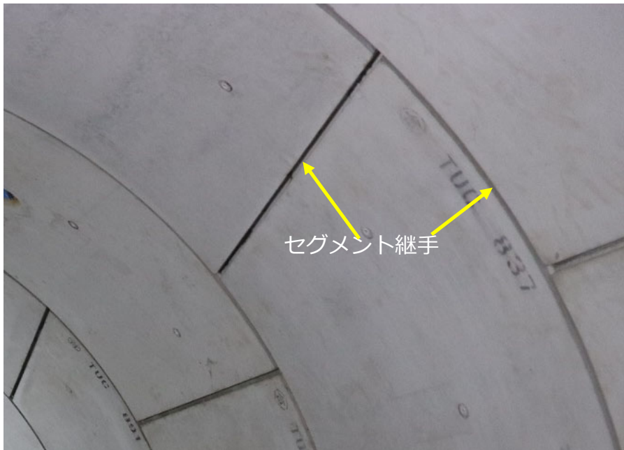
放水トンネル壁面 (充水前) の状況
