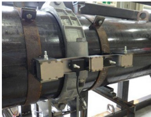
取付状況：工場モックアップ
