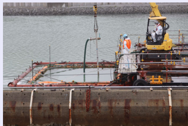
<海底再被覆工事(覆土施工)の様子>
