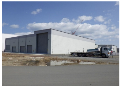
減容処理設備
