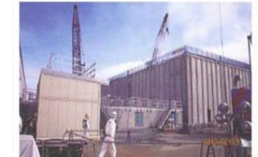
廃スラッジ一時保管施設
