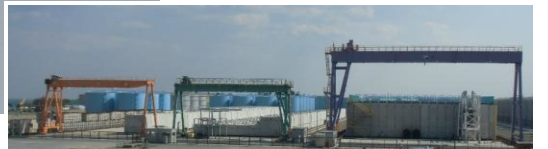
使用済吸着塔一時保管施設
