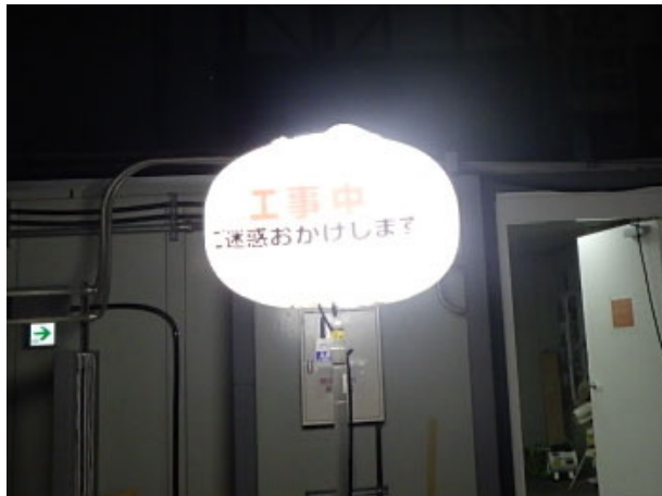
作業エリア全体を照らすバルーンライト（左）と手元を照らすバッテリーライト（右）により照度を確保
