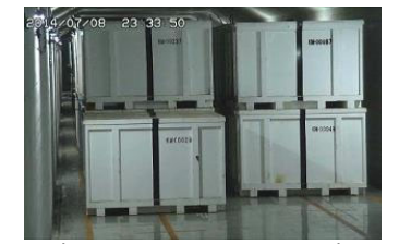
固体廃棄物貯蔵庫
