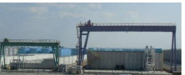
使用済吸着塔一時保管施設
