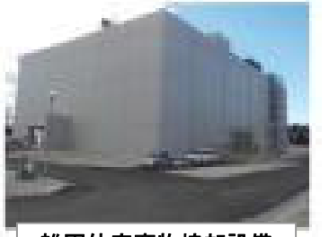
雑固体廃棄物焼却設備
