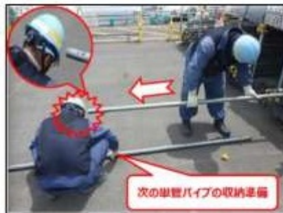
災害事例その1 単管パイプ接触による負傷（6月）
