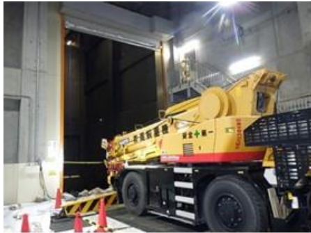
ラフタークレーン配置
