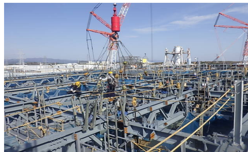
屋根鉄骨設置状況（撮影2024.4.2）
