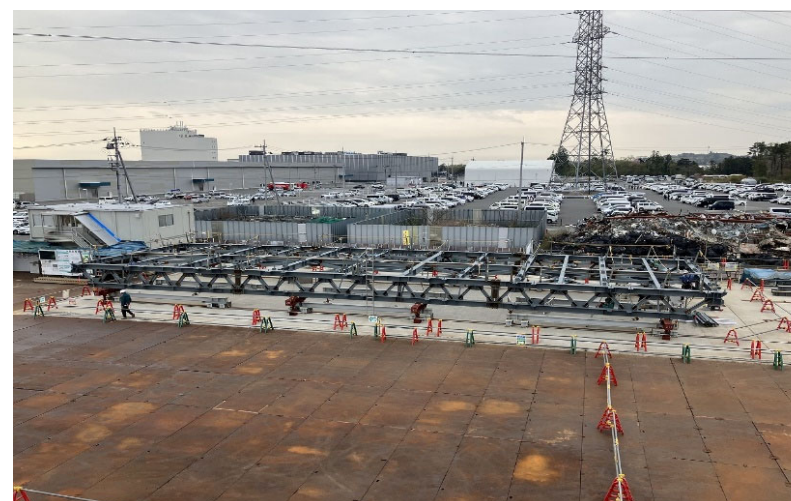
屋根鉄骨地組状況[構外]（撮影2024.4.17）
