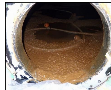
側板マンホールから内部撮影
