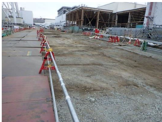
②敷き鉄板撤去、砕石敷き均し（2023.4）
