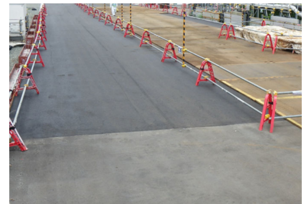
④アスファルト舗装完了（2023.9）
