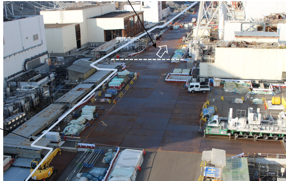
①フェーシング工事完了後（フェーシング上に鉄板敷設）：全景（2024.2）
