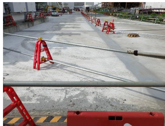
③コンクリート打設完了（2023.7）
