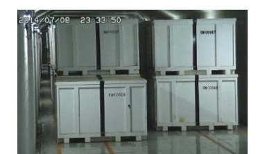
固体廃棄物貯蔵庫
