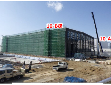
固体廃棄物貯蔵庫第10棟
