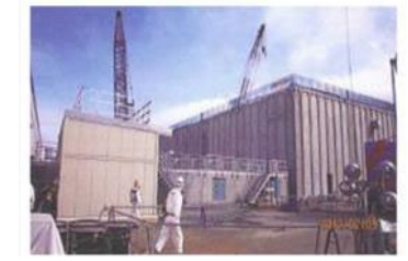
廃スラッジ一時保管施設
