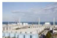
大型休憩所から見たタンクエリア（2015年10月29日）
