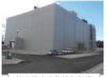
雑固体廃棄物焼却設備
