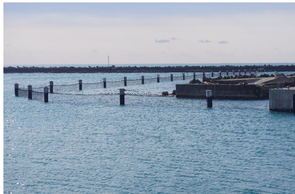
図2-2.1-4号機取水路開渠周辺(出口)を囲う状況
