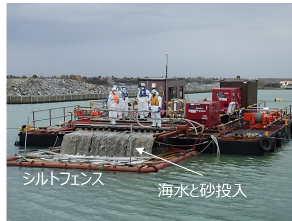
図10.ユニフロート台船による1層目の覆砂投入状況
