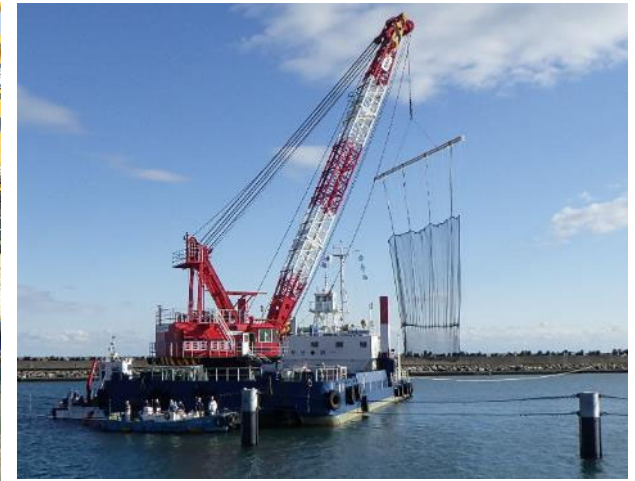
図5. 作業船で高耐久網を設置している状況 (2024年1月10日撮影)
