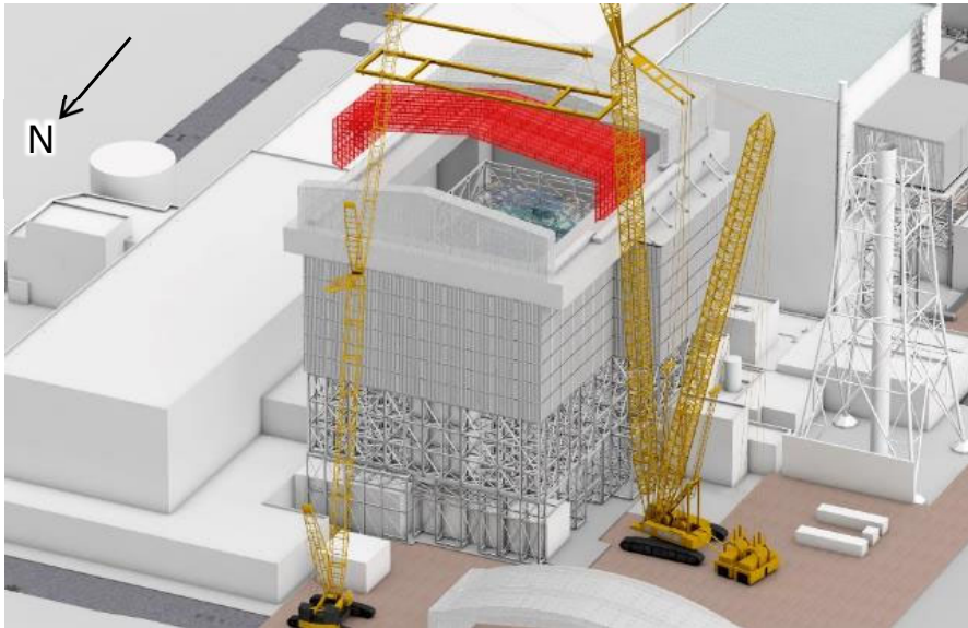
可動屋根設置中
