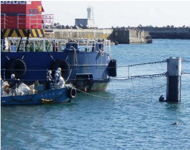
図6. 作業員が海上で高耐久網を設置している状況 (2024年1月10日撮影)
