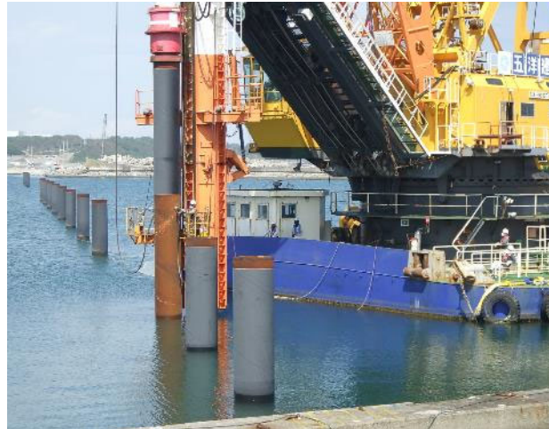
図4. 作業船で鋼管杭を設置している状況 (2023年9月19日撮影)
