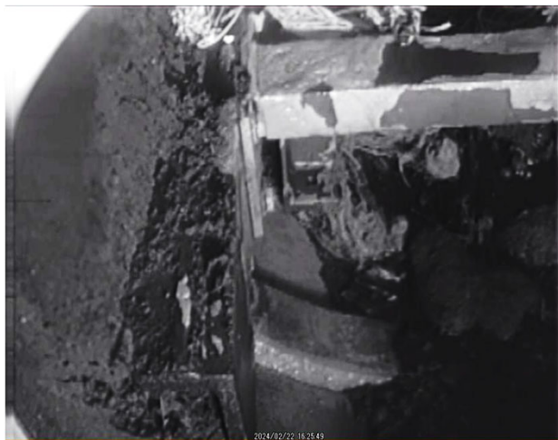
高圧水施工後 (X-6ペネ左下部)
