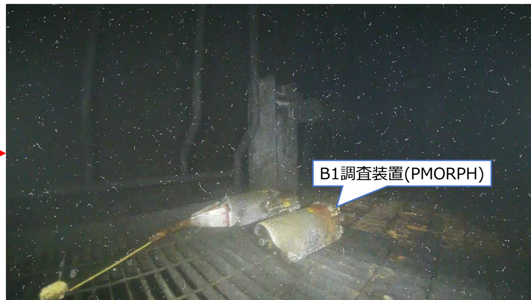
写真1.北側B1調査装置(PMORPH)の残置状況
