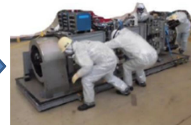
堆積物除去装置 (低圧水) 撤去
