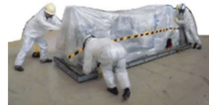
堆積物除去装置 (高圧水、AWJ) 撤去
