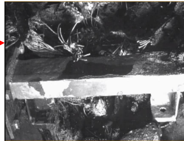
高圧水施工後 (X-6ペネ中央部)
