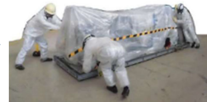
堆積物除去装置 （高圧水、AWJ）撤去
