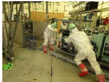
堆積物除去装置 （低圧水）設置
