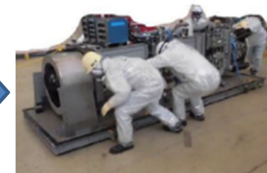
堆積物除去装置 （低圧水）撤去
