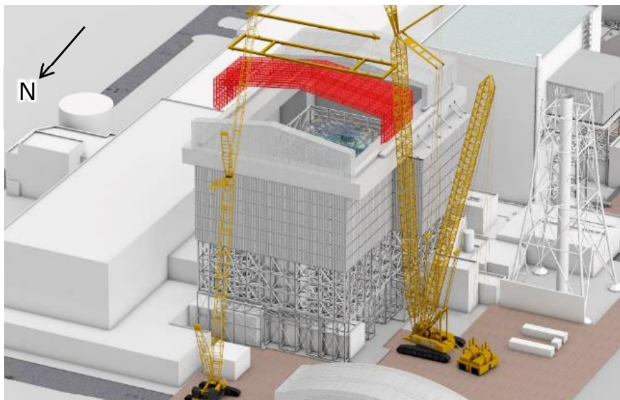
可動屋根設置中
