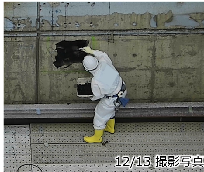
剥離除染剤塗布の状況
