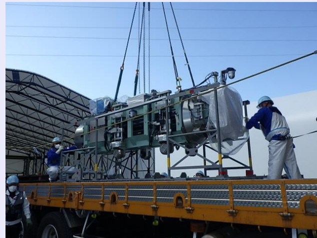
<堆積物除去装置の運搬状況>
