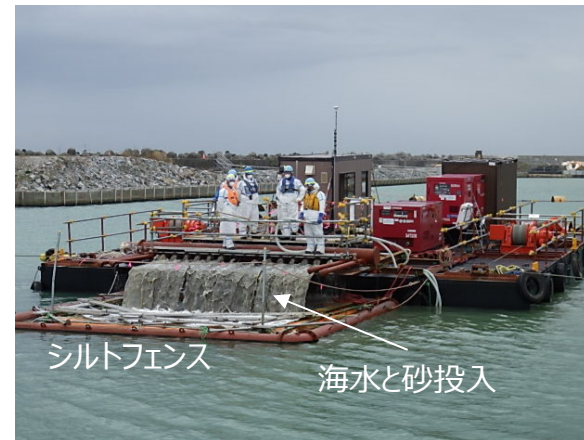
ユニフロート台船による覆砂投入状況
