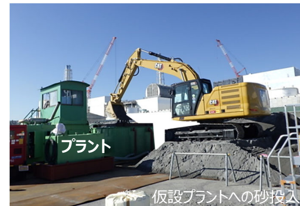
圧送配管 (海上設置)
