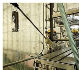
電動ウインチ +ツール介助にて 収納容器を吊出し
