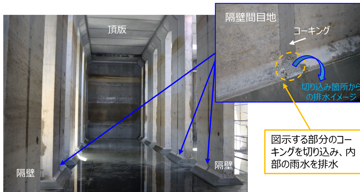
隔壁間目地の水抜き
