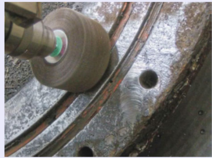
<X-6ペネ フランジ面の清掃の様子>
