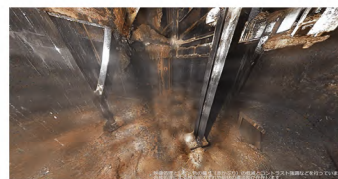
ベデスタル底部の状況（コンクリート除去処理後）
