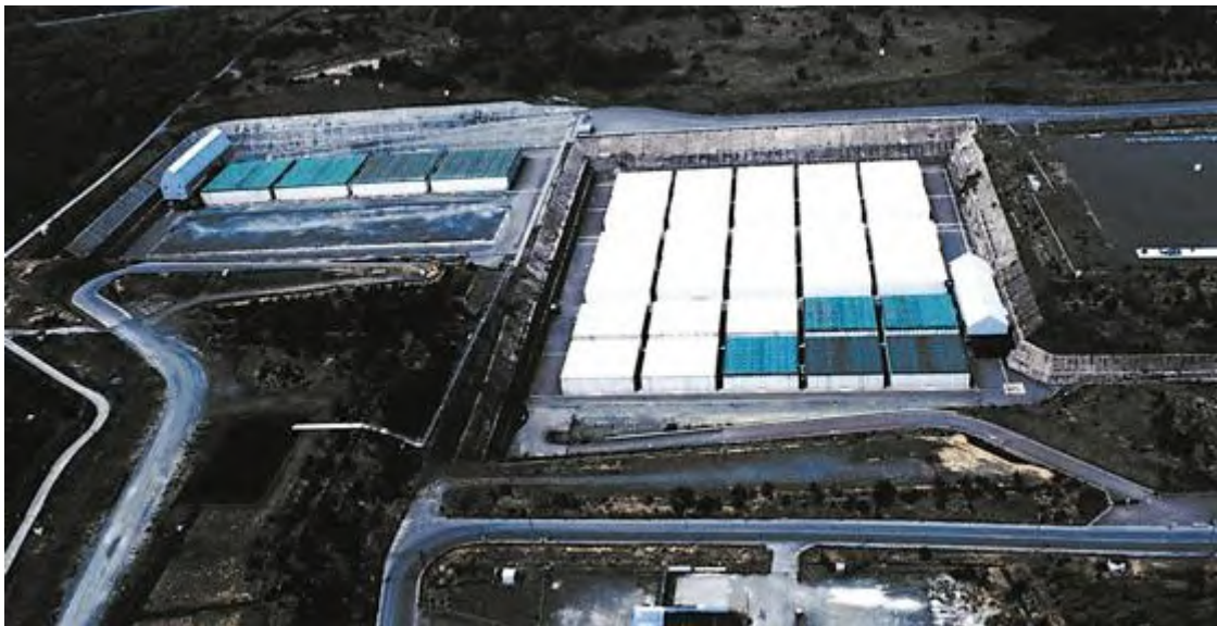
図 A12-2 日本原燃(株)低レベル放射性廃棄物埋設センター
