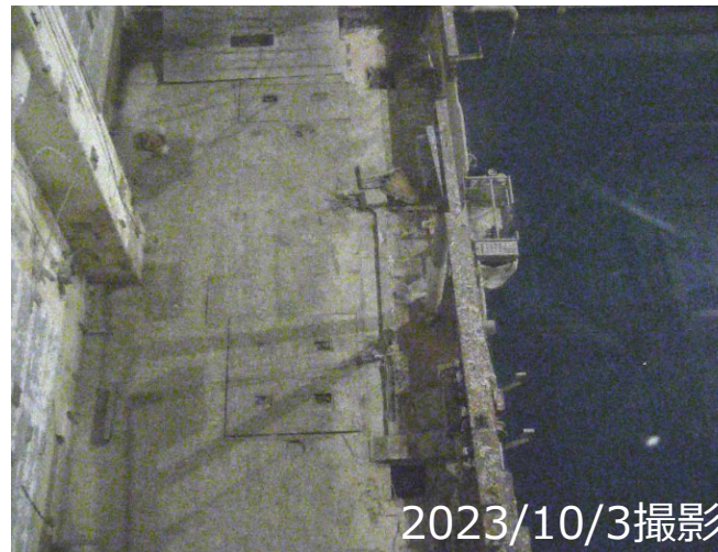
除染実施後の状況（南面）
