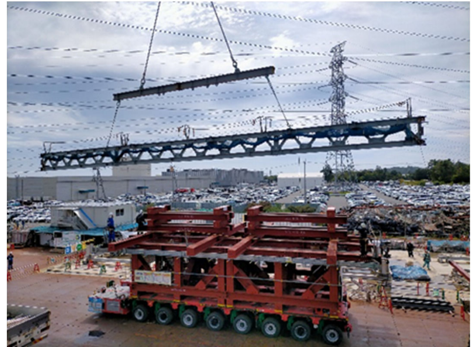
前室部ユニット積み込み状況（撮影：2023.09.26）
