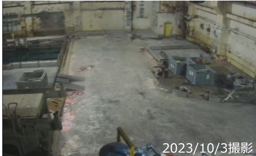
除染実施後の状況（西面）
