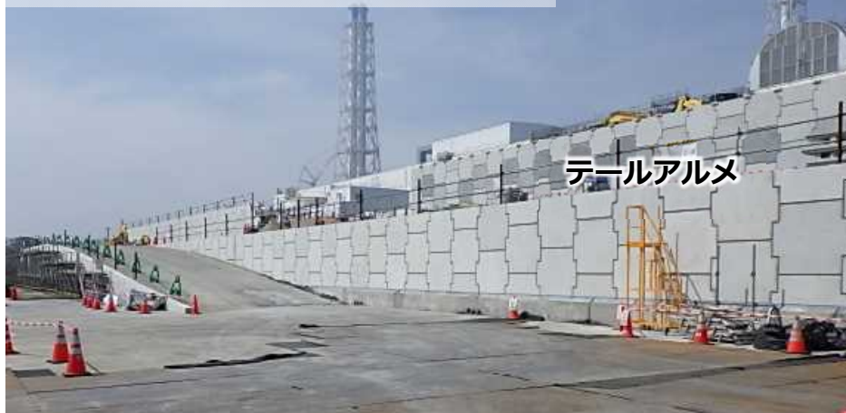
テールアルメ設置状況
