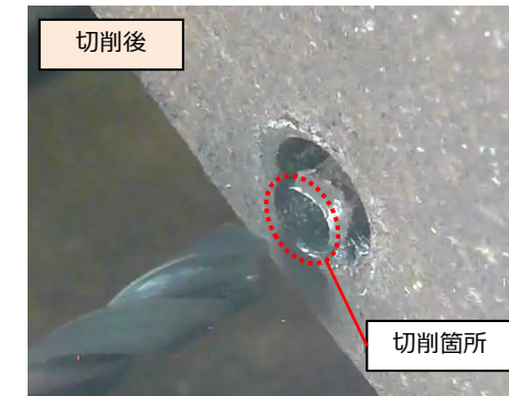
電動ドリルによるボルト切削状況
