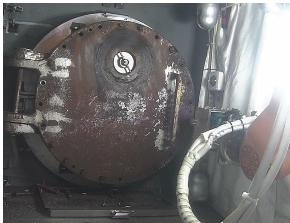
ボルト除去作業状況
