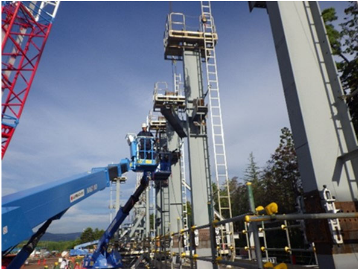
前室部ユニットの地組状況（撮影：2023.7.18）
