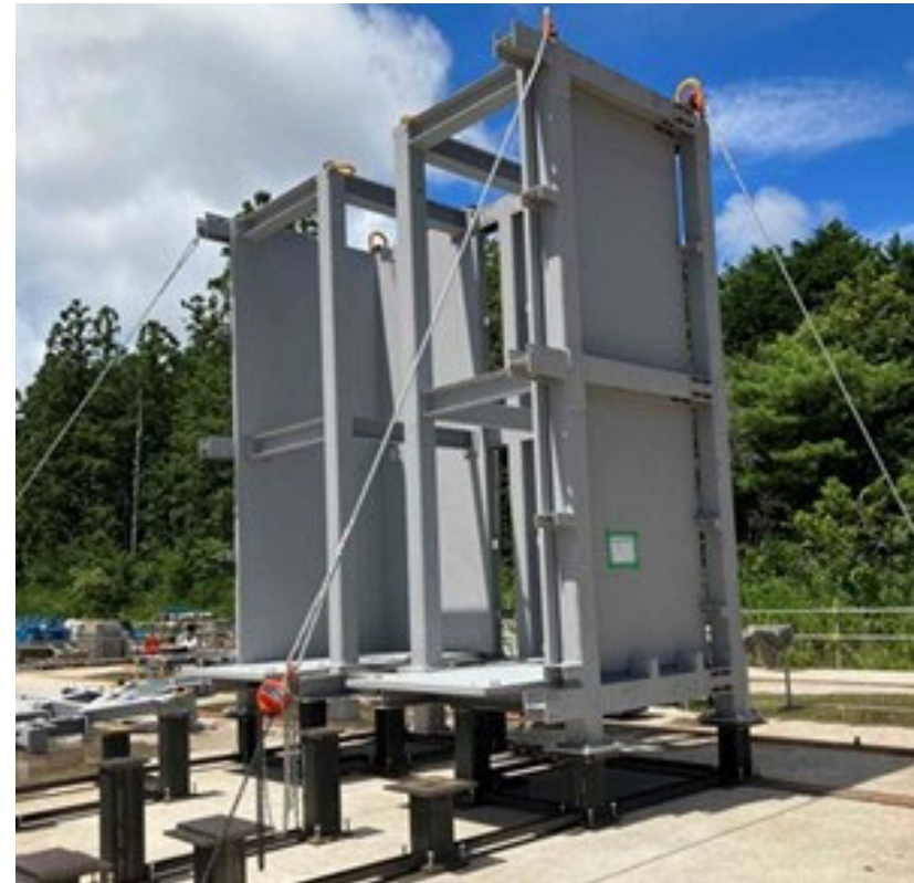
キャスク除染ピットの地組状況（撮影：2023.8.8）
