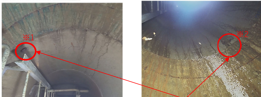
マンホール上部より約1 m下に穴を確認
