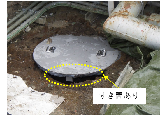
サンプ南東部のマンホール
