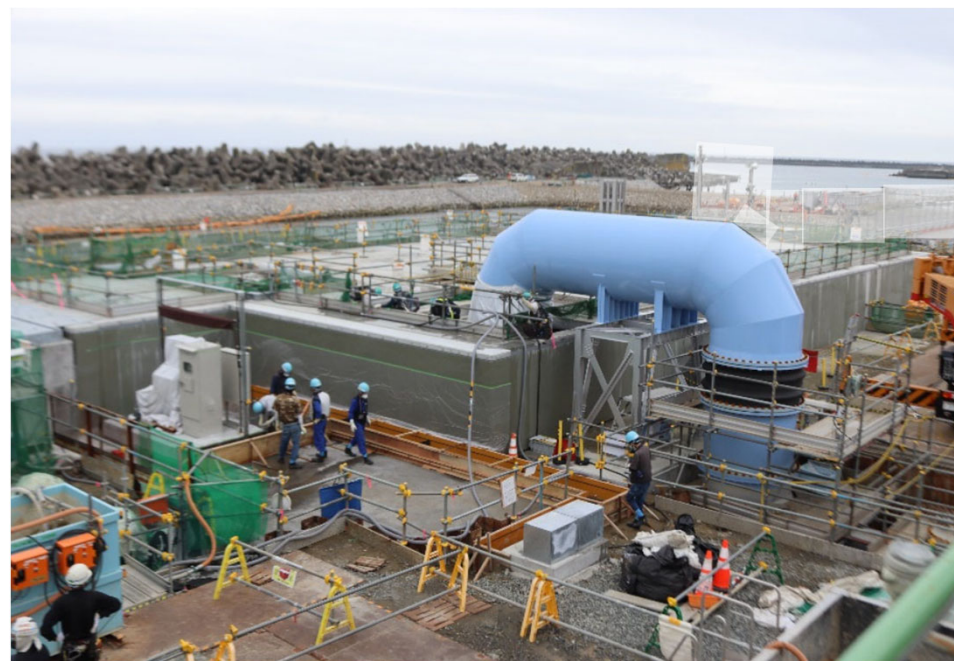
放水立坑（上流水槽）全景 [2023年6月23日撮影]
