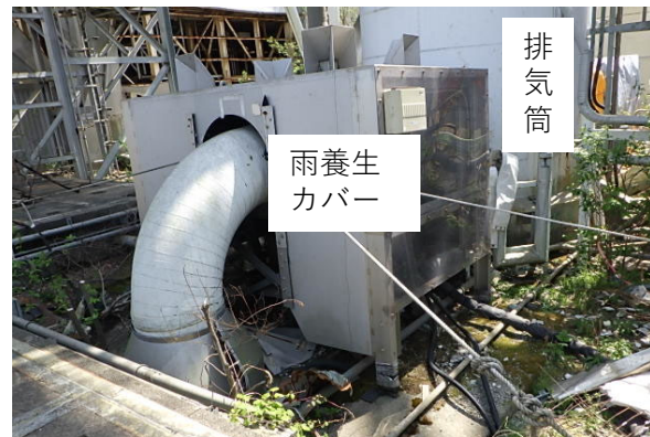
排気筒サンプ周辺状況
