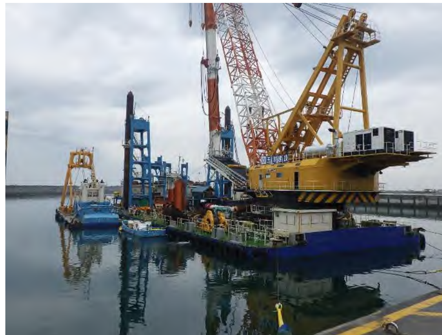
図2.作業船(物揚場での係留状況)
