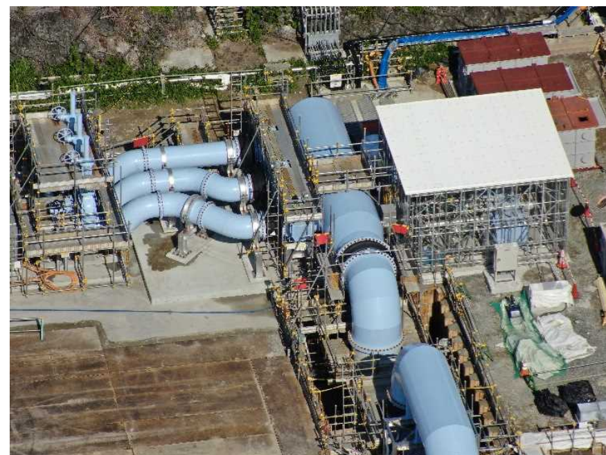
海水移送配管・海水配管ヘッド設置の状況
