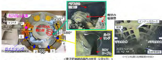
1号機 PCV内部調査実績
