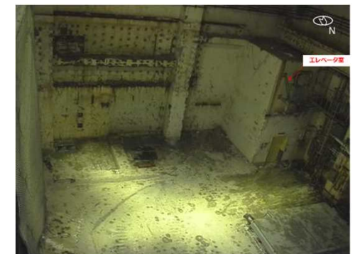
FHM操作室解体後
