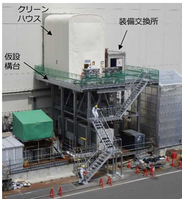
仮設構台、クリーンハウス、 装備交換所の設置
