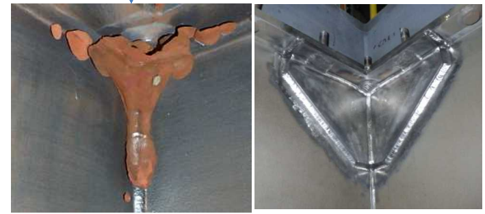
②天板隅部(左:補修前,右:補修後)
