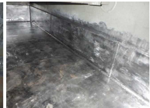
左：ケーシング内の清掃・ケレン前、中：ケレン後、右：初層溶接後
