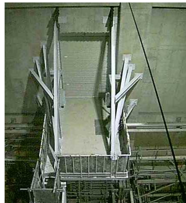
屋内ステージ設置 (プロセス主建屋内)
