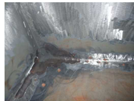
左：ケーシング内の清掃・ケレン前、中：ケレン後、右：初層溶接後
