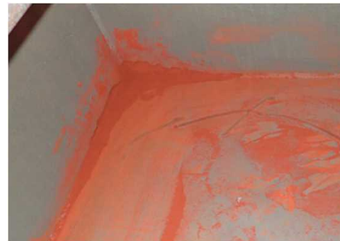
左：ケーシング内の清掃・ケレン前、中：ケレン後、右：初層溶接後
