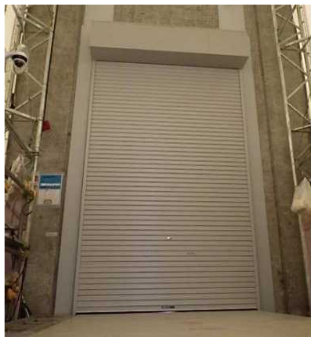
搬入口へシャッター設置 (クリーンハウス内)
