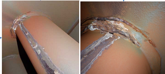
①バグフィルタ逆洗用圧縮空気配管と天板の付根部
