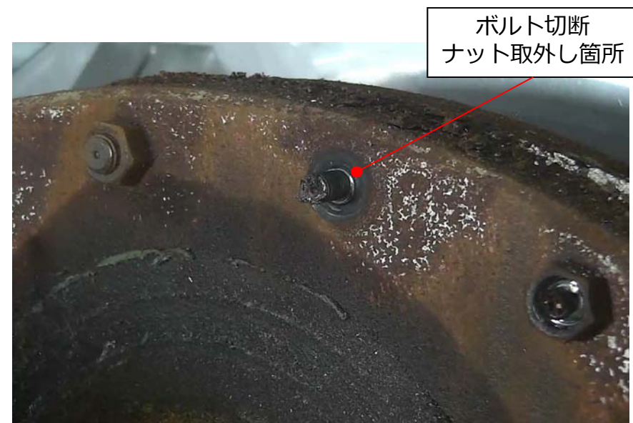
ボルト切断後
