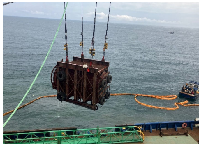
到達管の撤去作業の状況②
