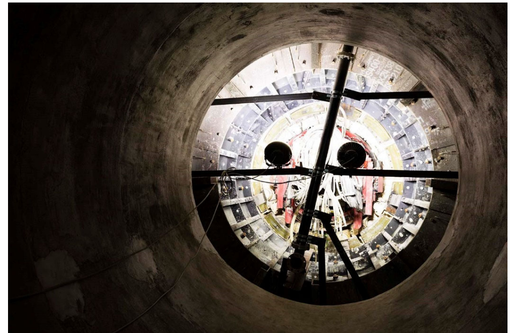
トンネル先端状況
