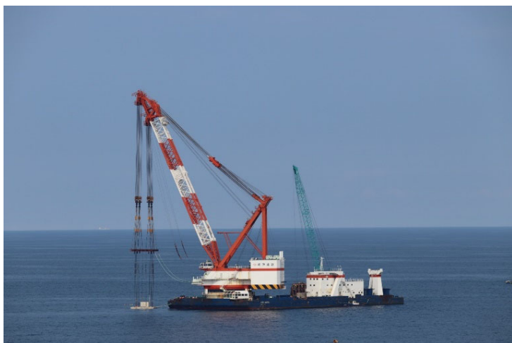
放水蓋設置作業の状況①
