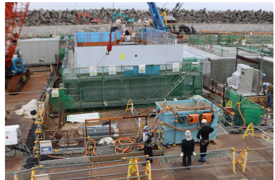
放水立坑（下流水槽） 全景
