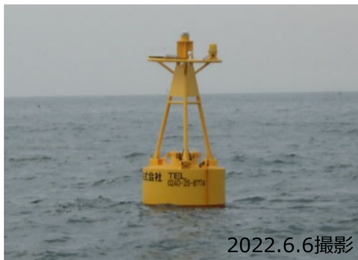
灯浮標設置状況
