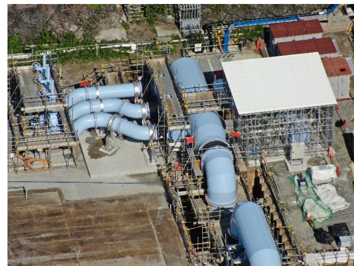
海水移送配管・海水配管ヘッダ設置の状況
