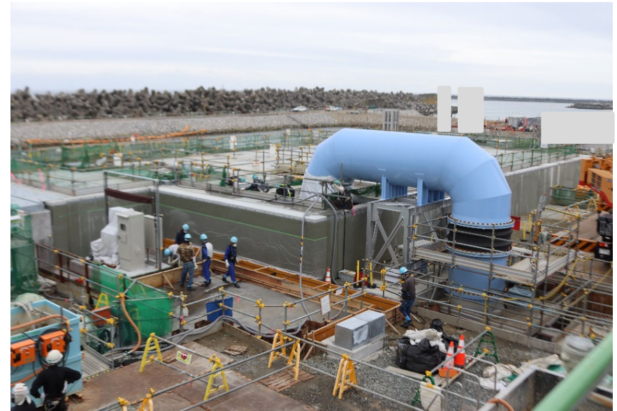
放水立坑（上流水槽） 全景
