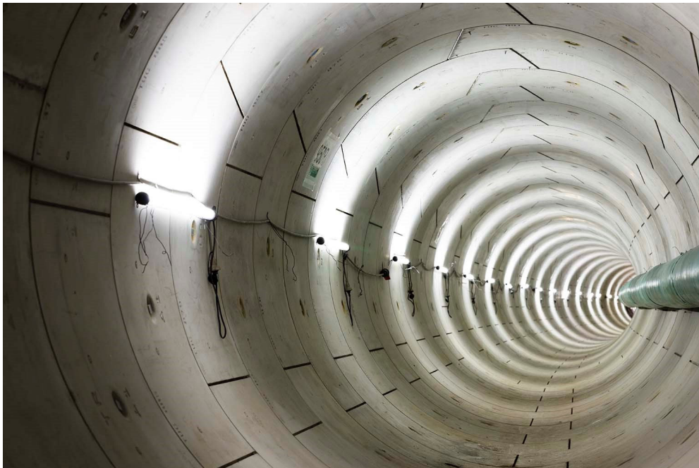
トンネル内部の状況
