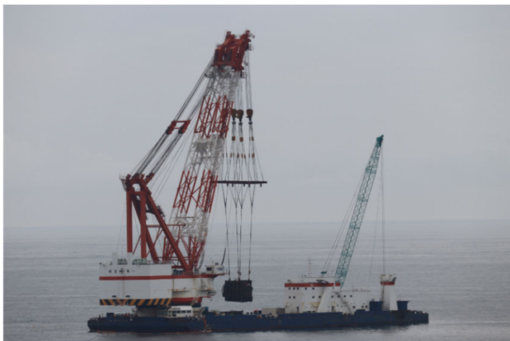
到達管の撤去作業の状況①
