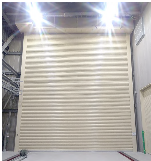
建屋南西 重量シャッター (建屋内より撮影)
