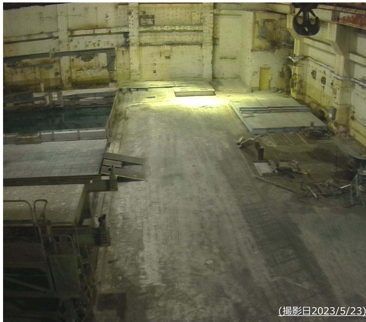
作業進捗状況
