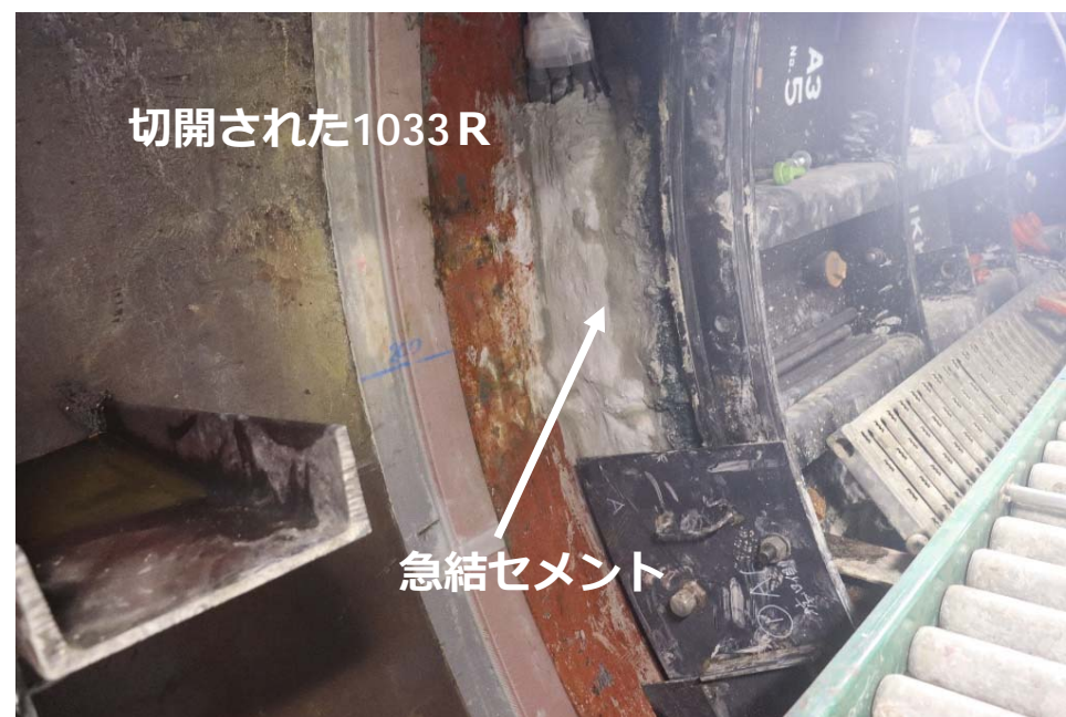
トンネル先端状況（止水工事の状況）
