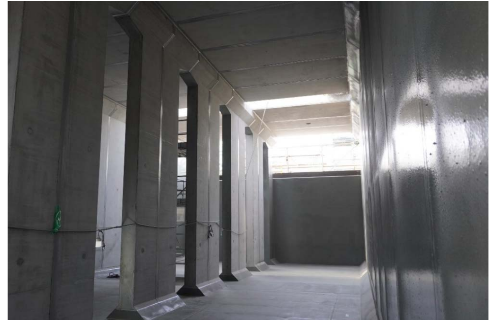
内部の状況（防水塗装完了）
