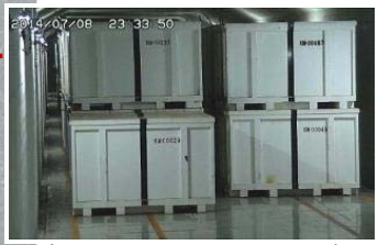
固体廃棄物貯蔵庫
