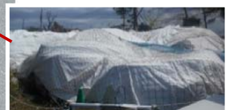
ガレキ (シート養生)
