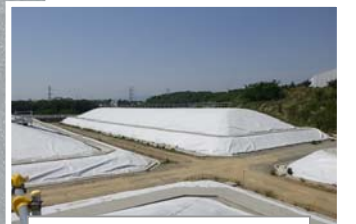
覆土式一時保管施設
