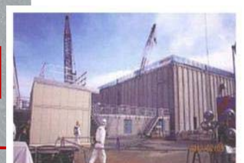
廃スラッジ一時保管施設
