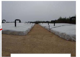
伐採木一時保管槽
