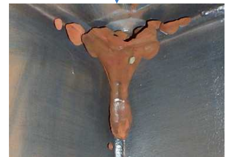
②天板隅部
