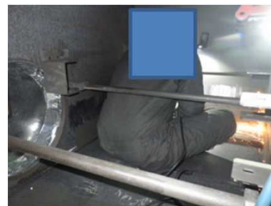
ケーシング内のケレン作業の様子
