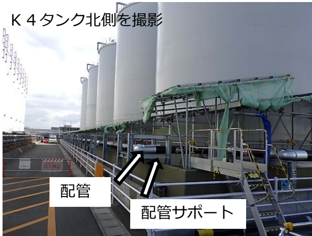
循環配管・サポート設置の状況
