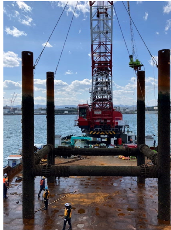
測量櫓（上段）撤去状況
