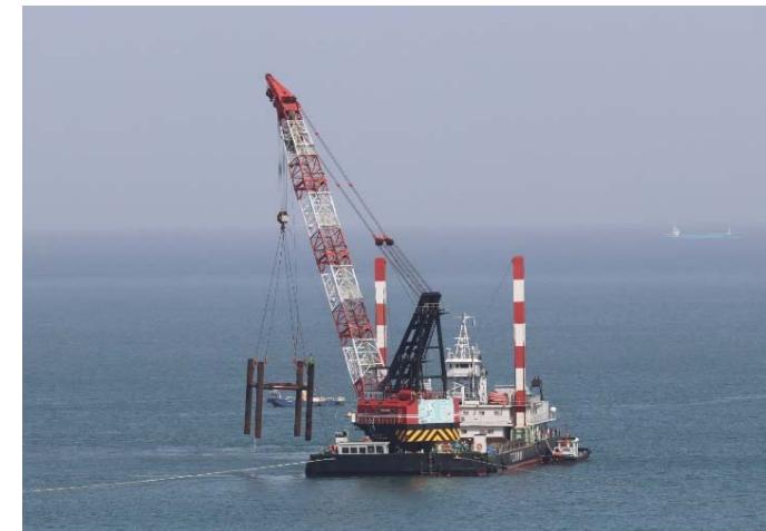
測量櫓（下段）撤去状況
