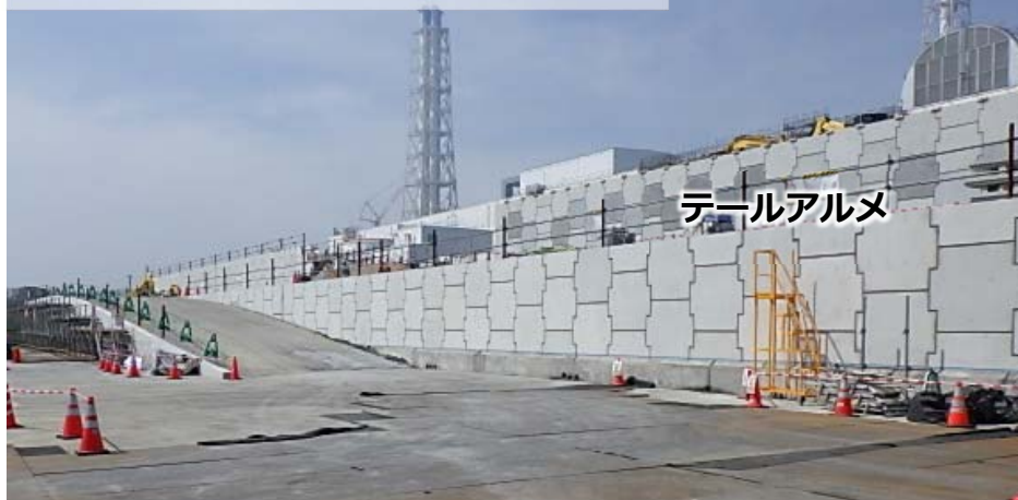
テールアルメ設置状況
