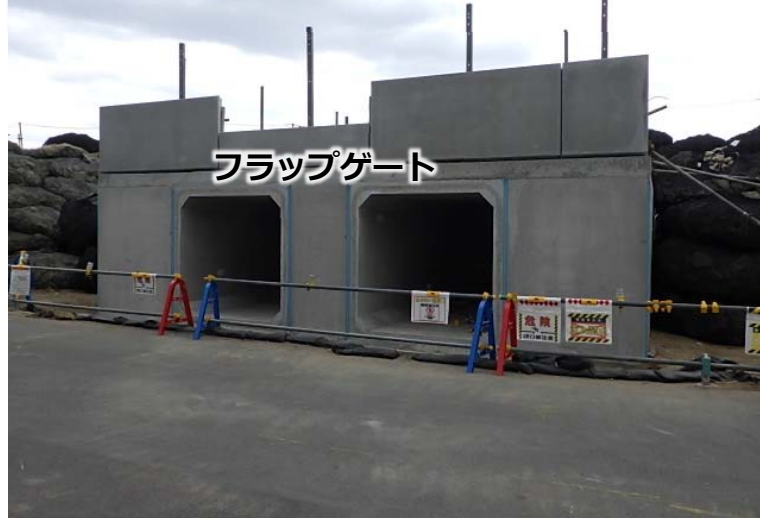
【写真⑥】フラップゲート施工中（2023.3）
