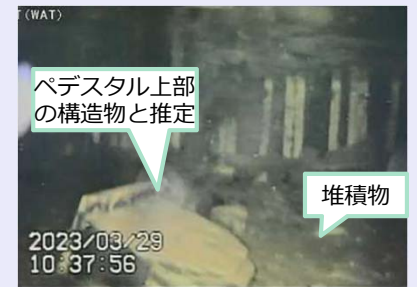
<ベDESTAL底部の状況>
