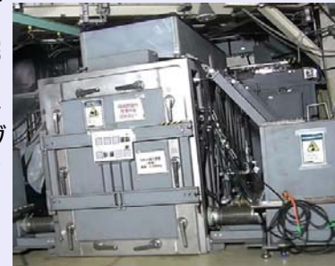
<隔離部屋据付の状況>
