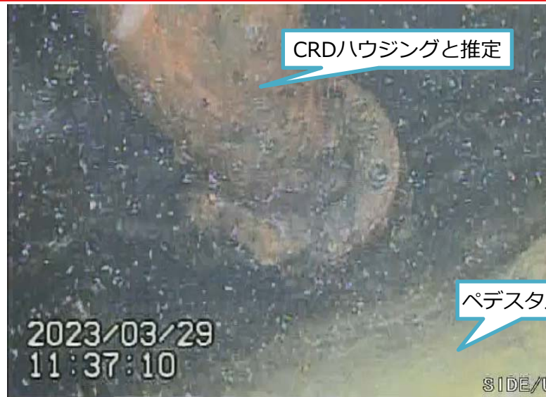
写真1. CRDハウジングと思われる構造物 (上側カメラで気中を撮影)
