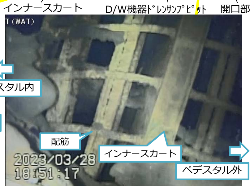
写真3.ペDESTAL開口右側配筋
