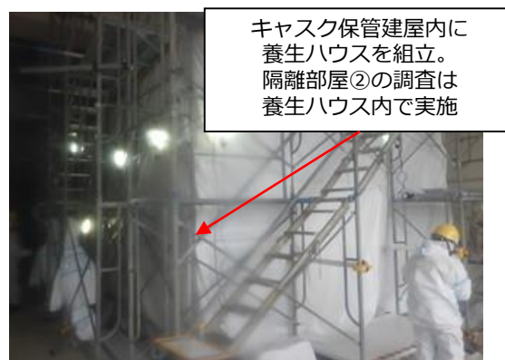
<隔離部屋②作業状況>
