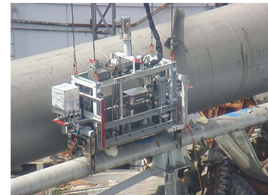
写真：2021年9月ウレタン注入時
