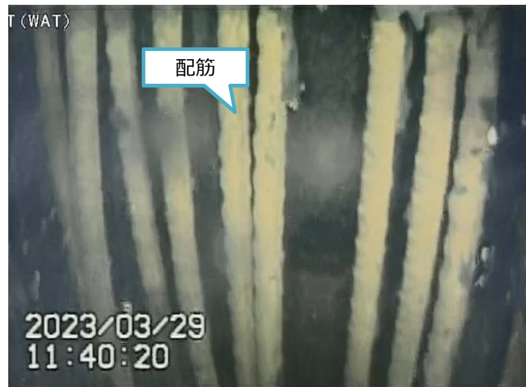
写真2.ペDESTAL内基礎部(下部)
