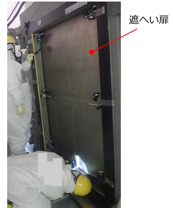
加圧確認状況
