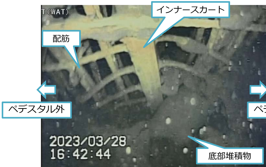
写真2.ペDESTAL開口左側配筋
