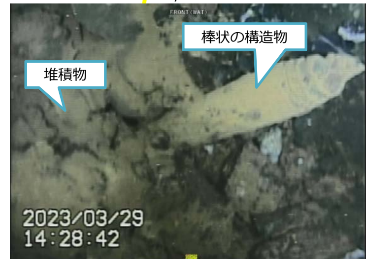
写真3.棒状の構造物(ペDESTAL底部)
