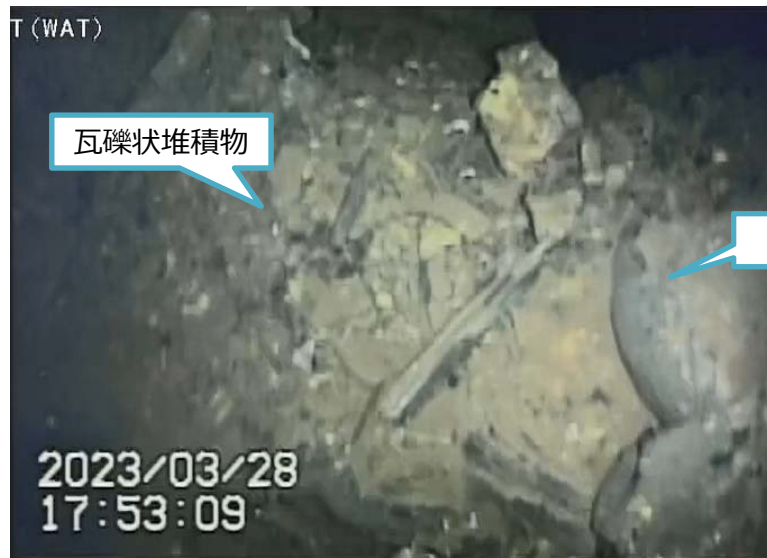
写真2.ペDESTAL内開口付近堆積物
