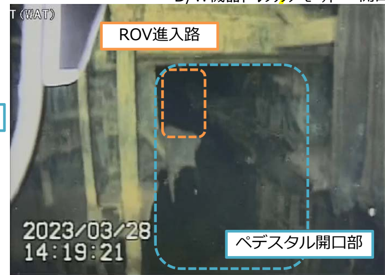
写真3.ペDESTAL開口部
