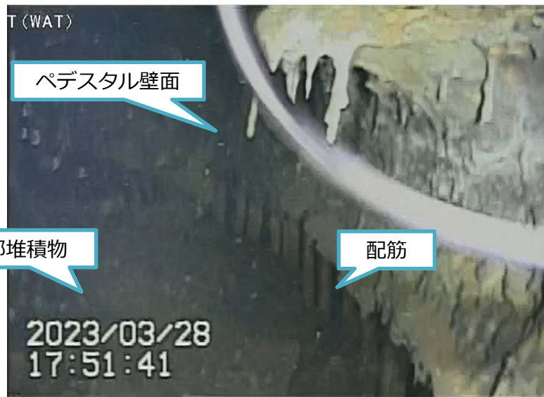
写真1.ペDESTAL内基礎部配筋 (ペDESTAL開口部内にて撮影)
