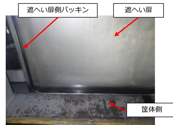
<扉側パッキン取付>
