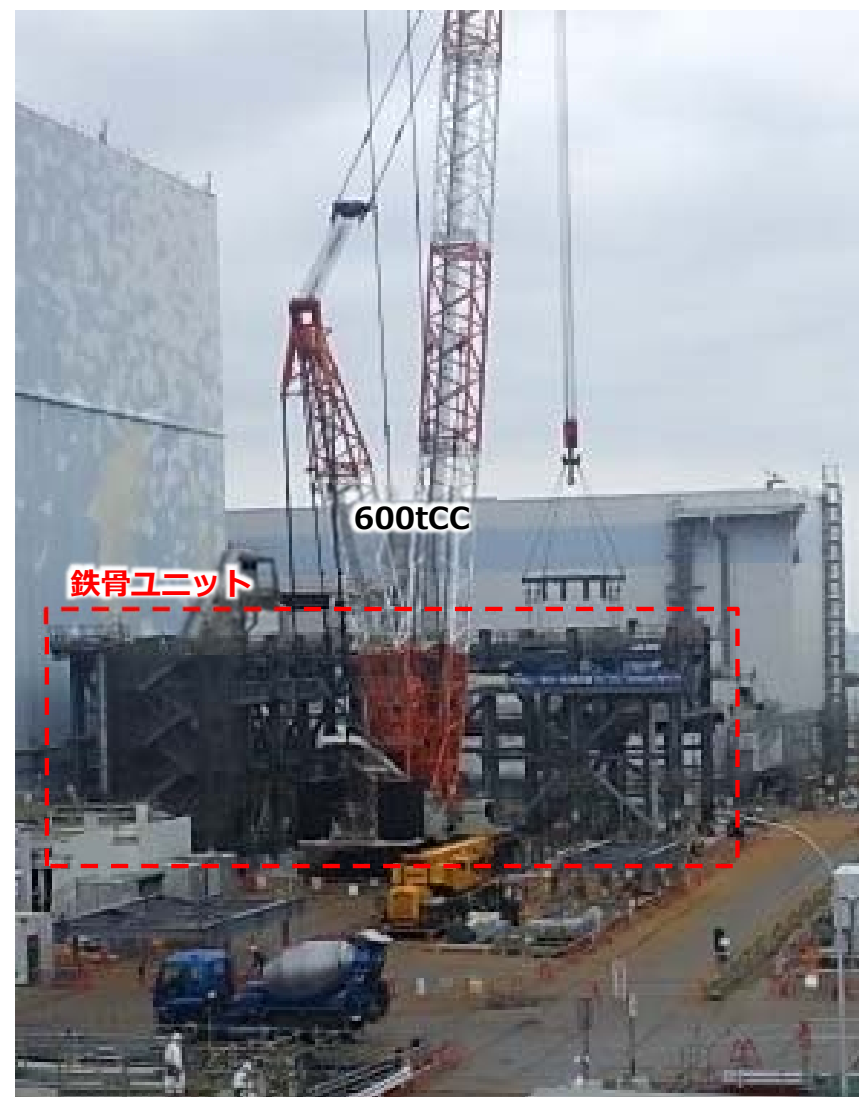
2号機原子炉建屋南側ヤード全景 (撮影：2023.3.17)
