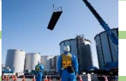
溶接タンク建設中の様子
