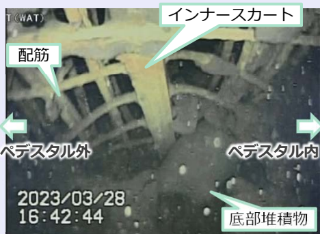
<ペDESTAL開口左側配筋の状況>
