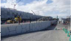
日本海溝津波防潮堤建設中の様子
