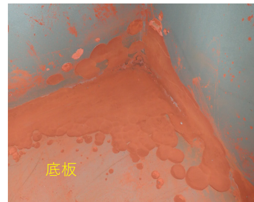
ケーシングの腐食の状況
