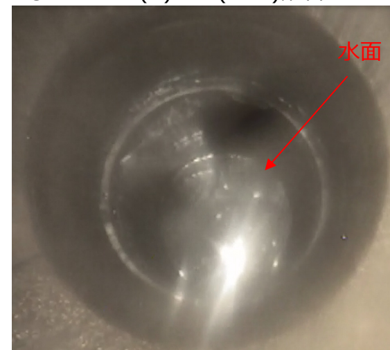
③RCW-Hx(C)入口(垂直)配管の水面
