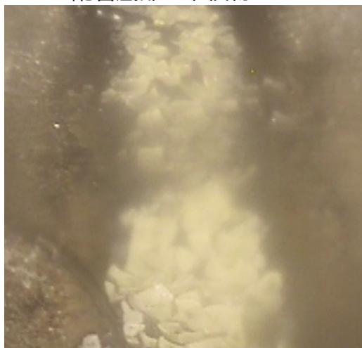
①RCW-Hx(A)(B)側の配管底部の堆積物
