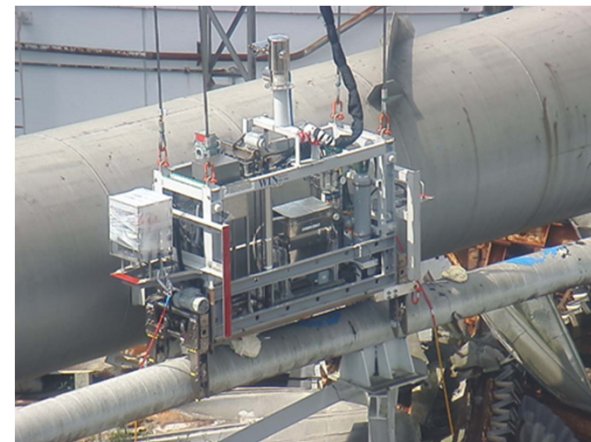
写真：2021年9月ウレタン注入時
