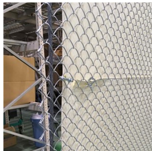
養生カーテン (金網と不燃シートで構成)
