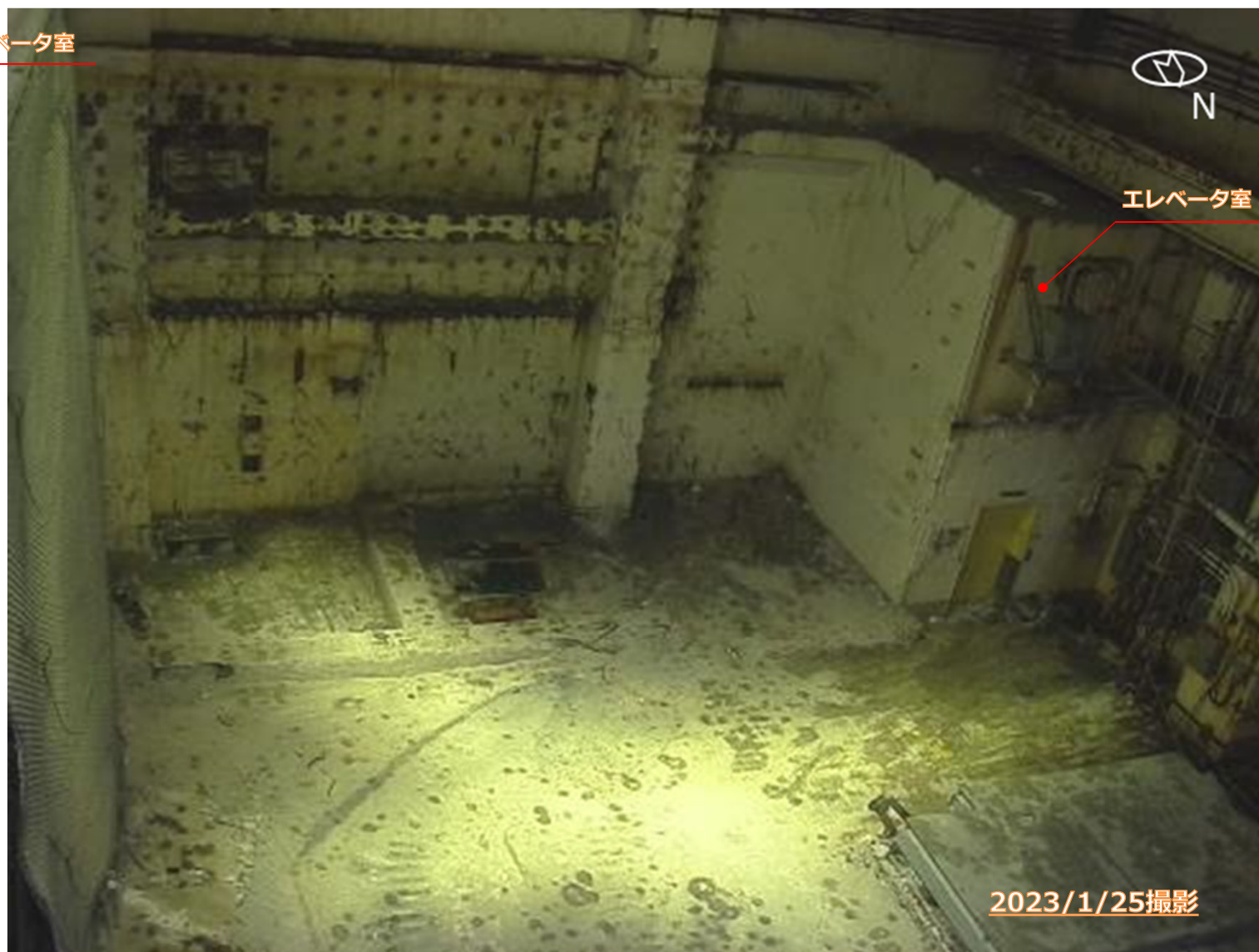
解体後の現場状況写真
