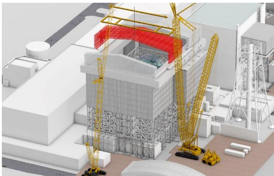
可動屋根設置中
