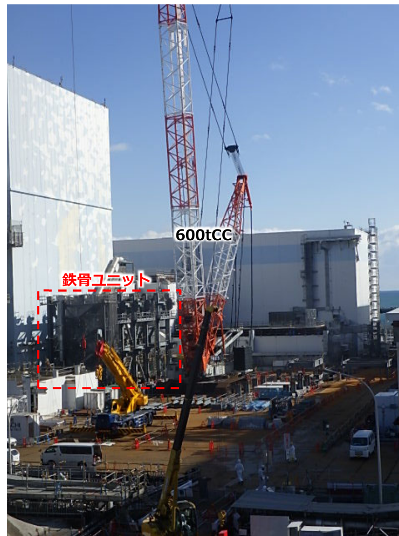
2号機原子炉建屋南側ヤード全景 (撮影：2023.2.10)
