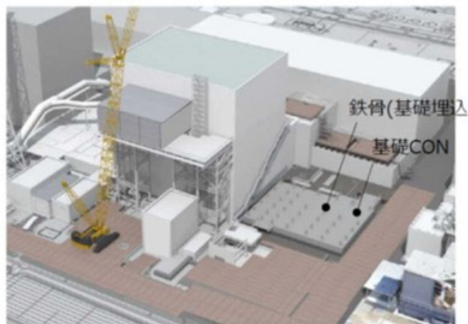
②構台鉄骨建方(0層)・基礎CON打設完了
