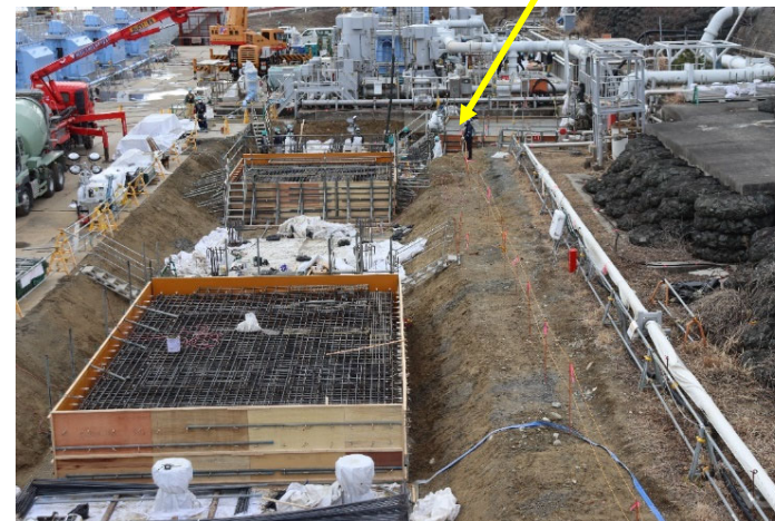
海水移送配管基礎の構築状況
