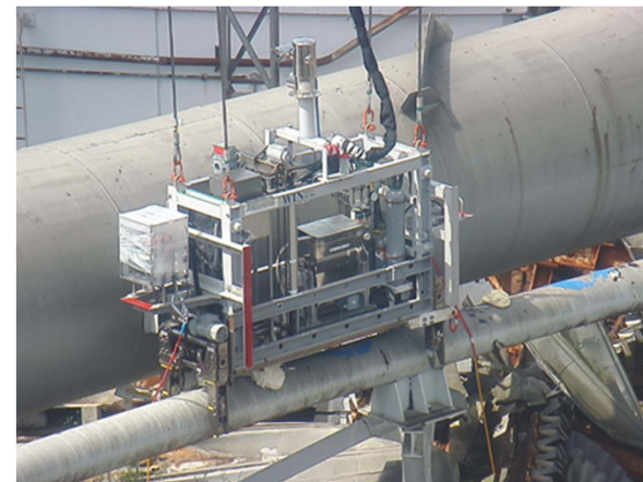
写真：2021年9月ウレタン注入時
