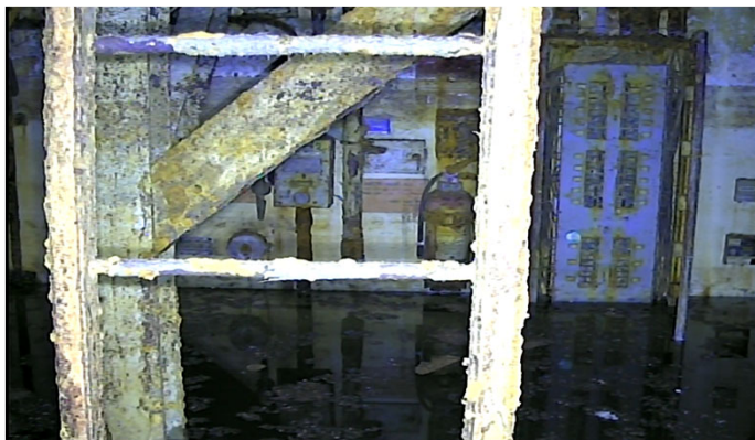
④西（壁面、制御盤）
