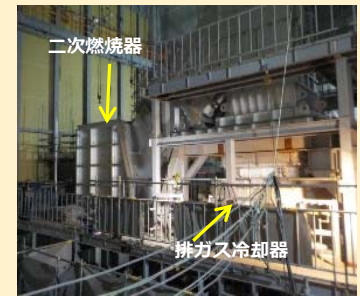
二次燃焼器 排ガス冷却器 主要機器
